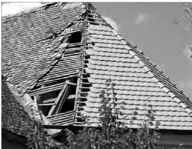
Gertianosch: Das Kirchendach vor der Renovierung und danach.
