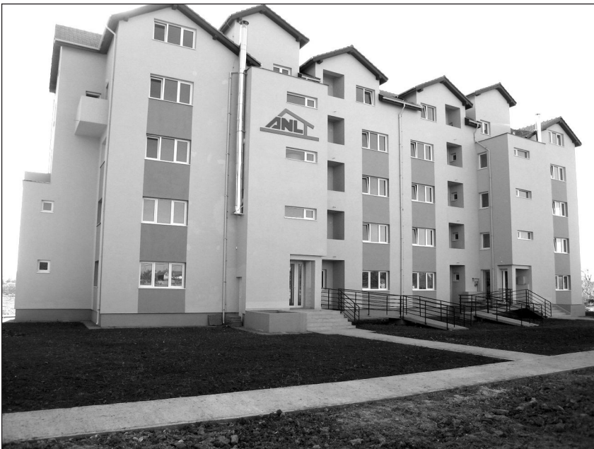
Neben der Futoker Grundschule wurde im Jahr 2010 ein Wohnblock mit 30 Apartments für junge Familien fertiggestellt. (Foto: Stadt Hatzfeld)
